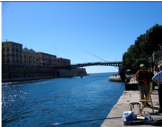
Taranto Ponte Girevole sul Canale Navigabile Che unisce Mar Piccolo a Mar Grande
